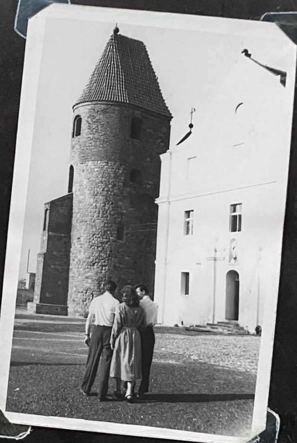
Stara wieża łosielna z XII w w stylu romańskim, zamieniona się w razie potrzeby na basztę obronną.
